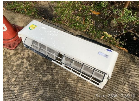
รูปที่ 68 การล้างแผ่นกรองอากาศของเครื่องปรับอากาศ
