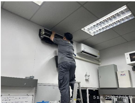
รูปที่ 68 การล้างแผ่นกรองอากาศของเครื่องปรับอากาศ
